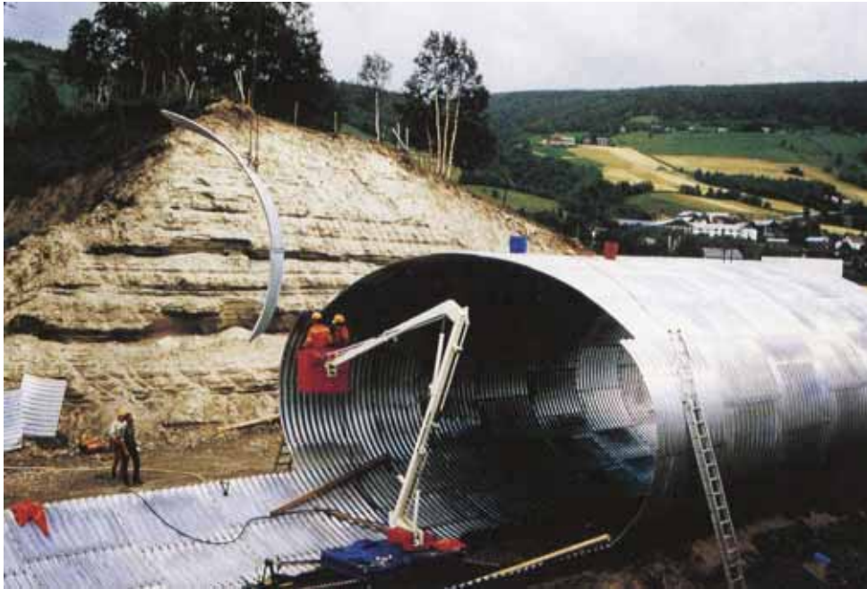
Figur 12. 25 Formonterte plater heises på plass.
