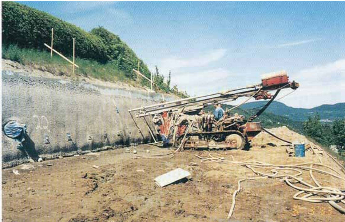
Figur 16.35 Montering av jordnagler ved Vingrom kirke i Oppland
