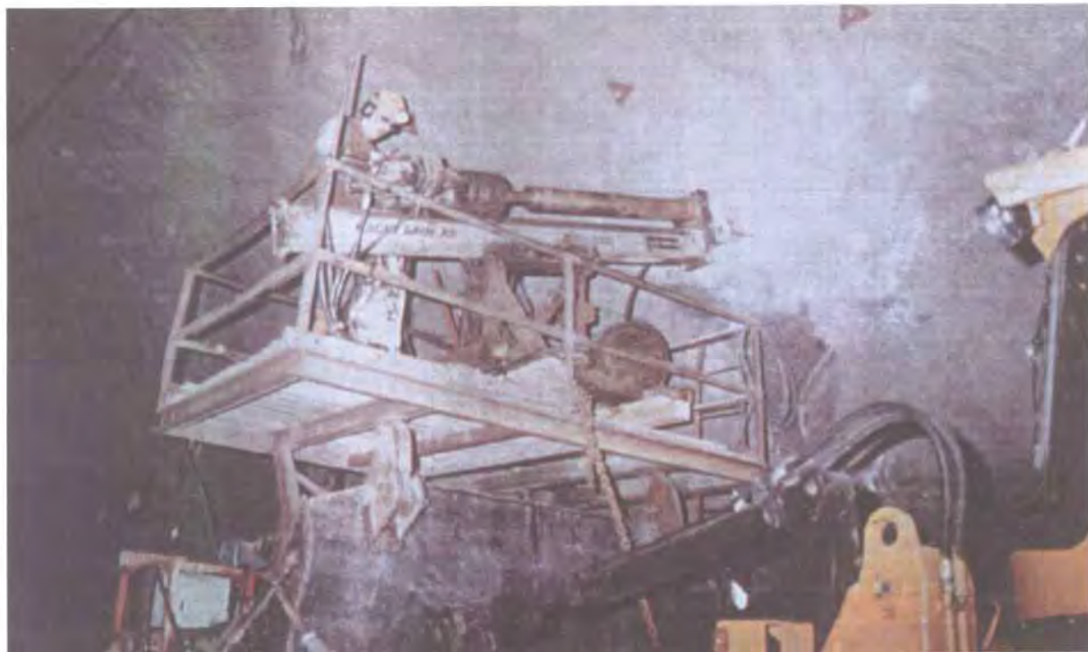
Ut boring av bolter for kvalitetskontroll. (Foto: K. B. Pedersen)
