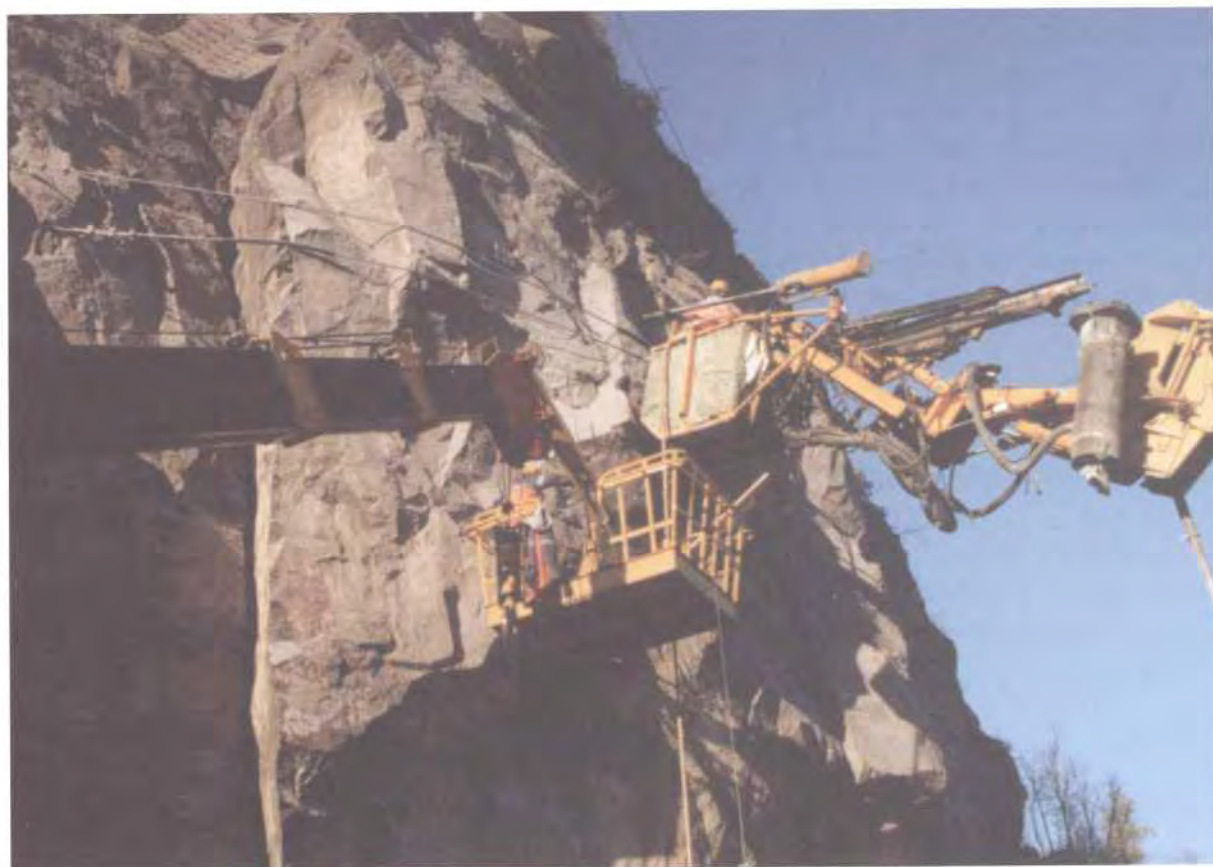
Forankring av større fjellblokk. (Foto: K. B. Pedersen)
