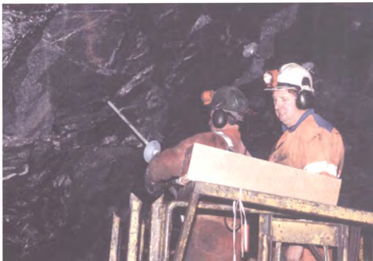
Montering av polyesterforankret bolt. (Foto: H. Berg)
